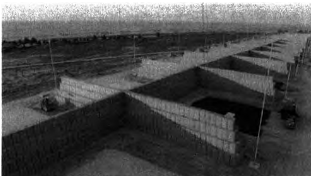
Рис.1 Вариант установки габионов насыпного типа
